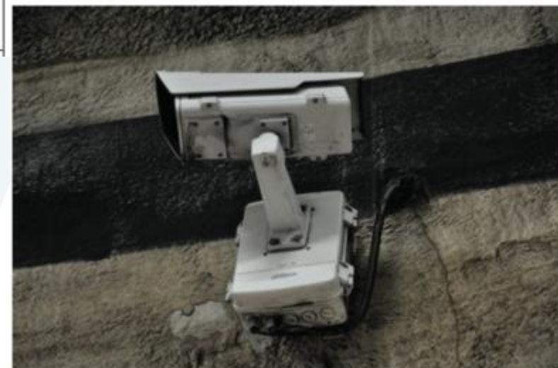
Foto 1: Camera die gebruikt wordt voor verkeersdetectie.
