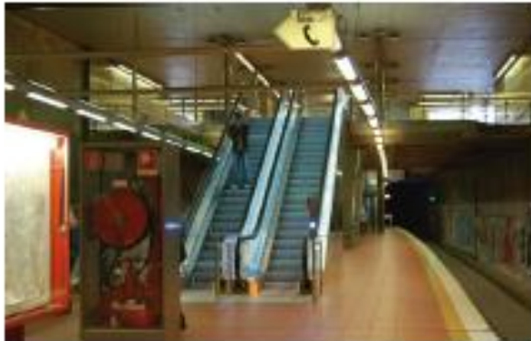
Bild 2 Ungeschützte Treppenanlage und offene Verteilerebene
