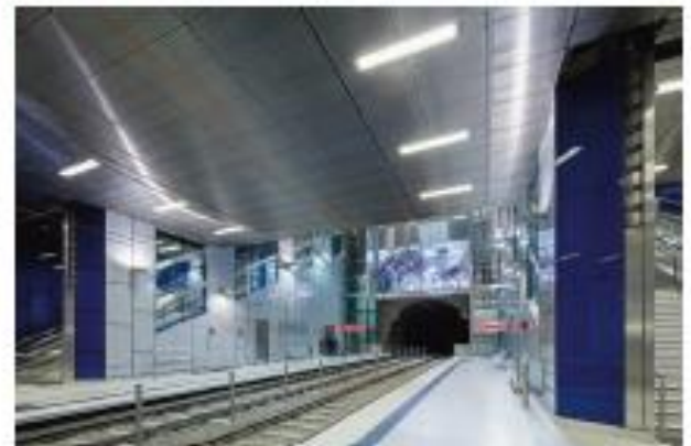
Bild 3 Station Schadowstraße der Wehrhahn-Linie in Düsseldorf (Quelle: Jörg Hempel)
