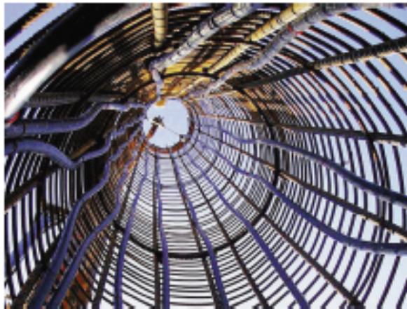
Bild 1 Bewehrungskorb eines Bohrpfahls mit Absorberleitungen vor dem Betoniervorgang [8]
