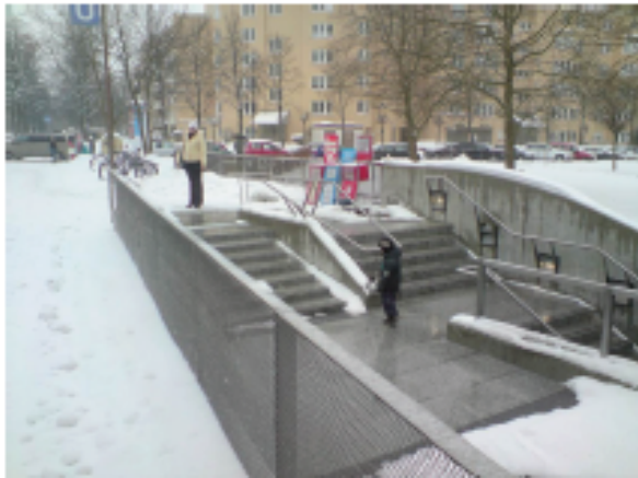
Bild 3 Geothermisch beheizte Treppenanlage an einem Zugang zur Münchener U-Bahn im Betrieb (Quelle: Stadtwerke München)
