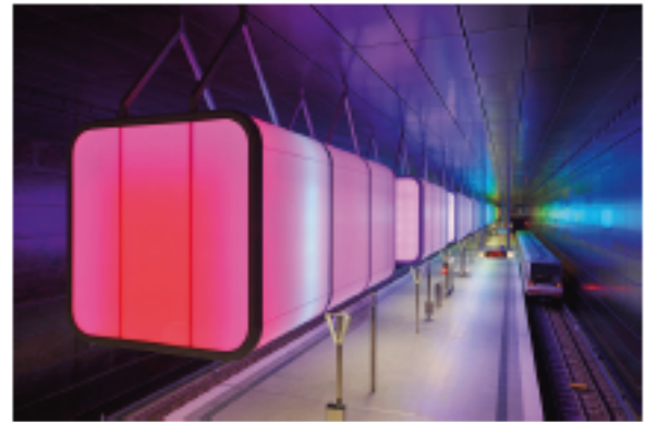
Bild 7 LED-Lichtcontainer im Betrieb mit geschlossener Tür
