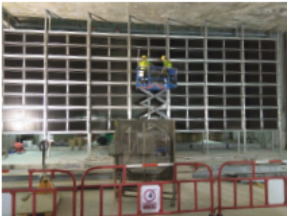
Bild 3 Montage eines Partikelfilters im Westgebäude des Central-Wan Chai Bypass-Tunnels
